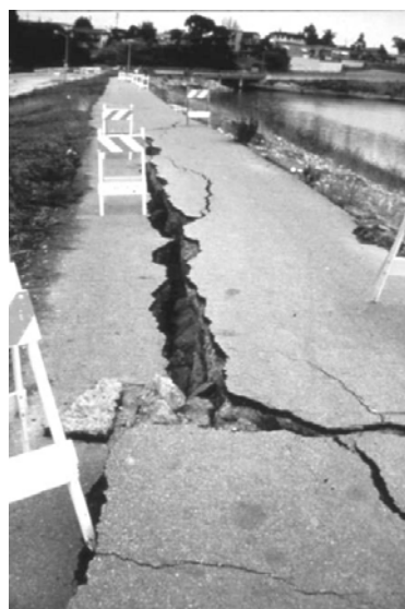
Figura 39 – Expansión Lateral. Terremoto de Loma Prieta, Octubre 17, 1989. La expansión lateral dañó el nivel de la carretera a lo largo del Río San Lorenzo.
