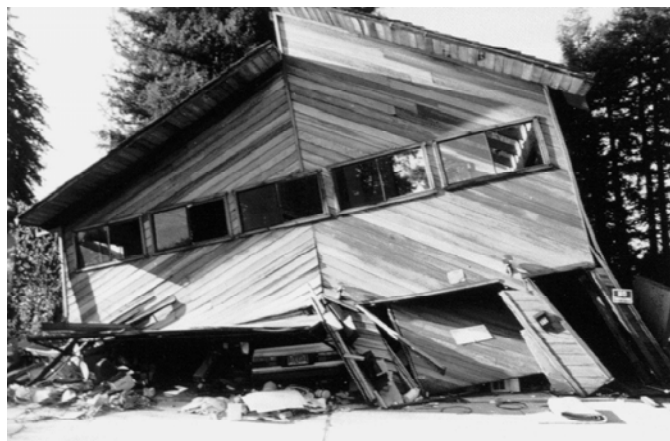
Figura 29 – Esta casa de montaña fue construida sobre un garaje y las paredes no fueron lo suficientemente fuertes para soportar un terremoto.
