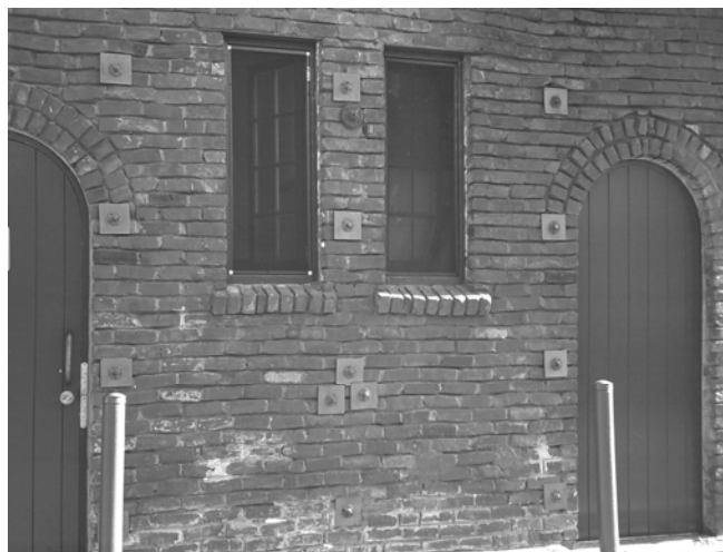
Figura 28 – Pared de mampostería sin refuerzo, atornillada a un marco de acero interior.
